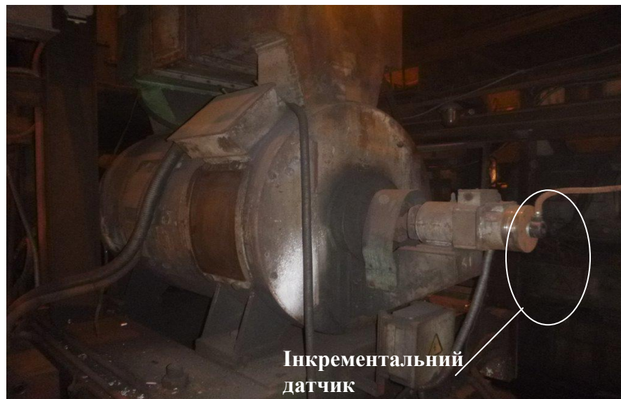
Рис. 4.15. Установка інкрементального датчика на двигуні моталки
